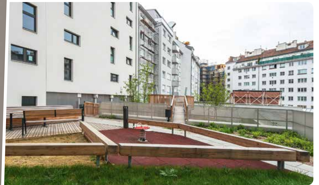
Vom Erdgeschoß führt eine geschwungene Holzwendelrampe in den ersten Stock hinauf. Hier befinden sich der Kinderspielplatz sowie ein großer Fahrradabstellraum.
